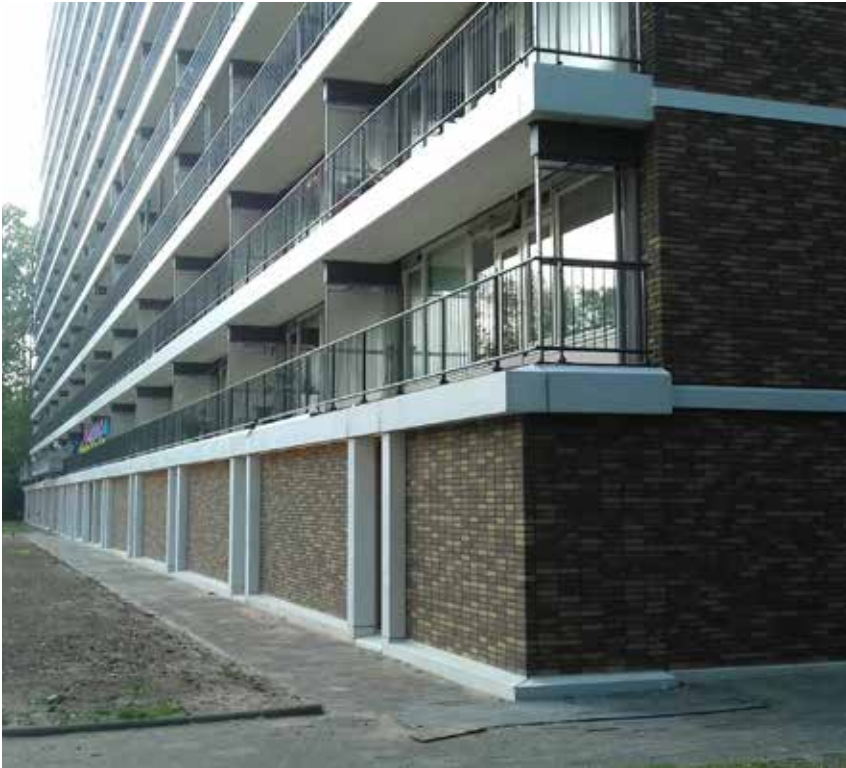
De lichtbeton elementen in de plint.
