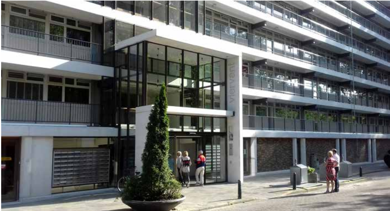
De vernieuwde entree bestaat uit 2 L-vormige elementen.
