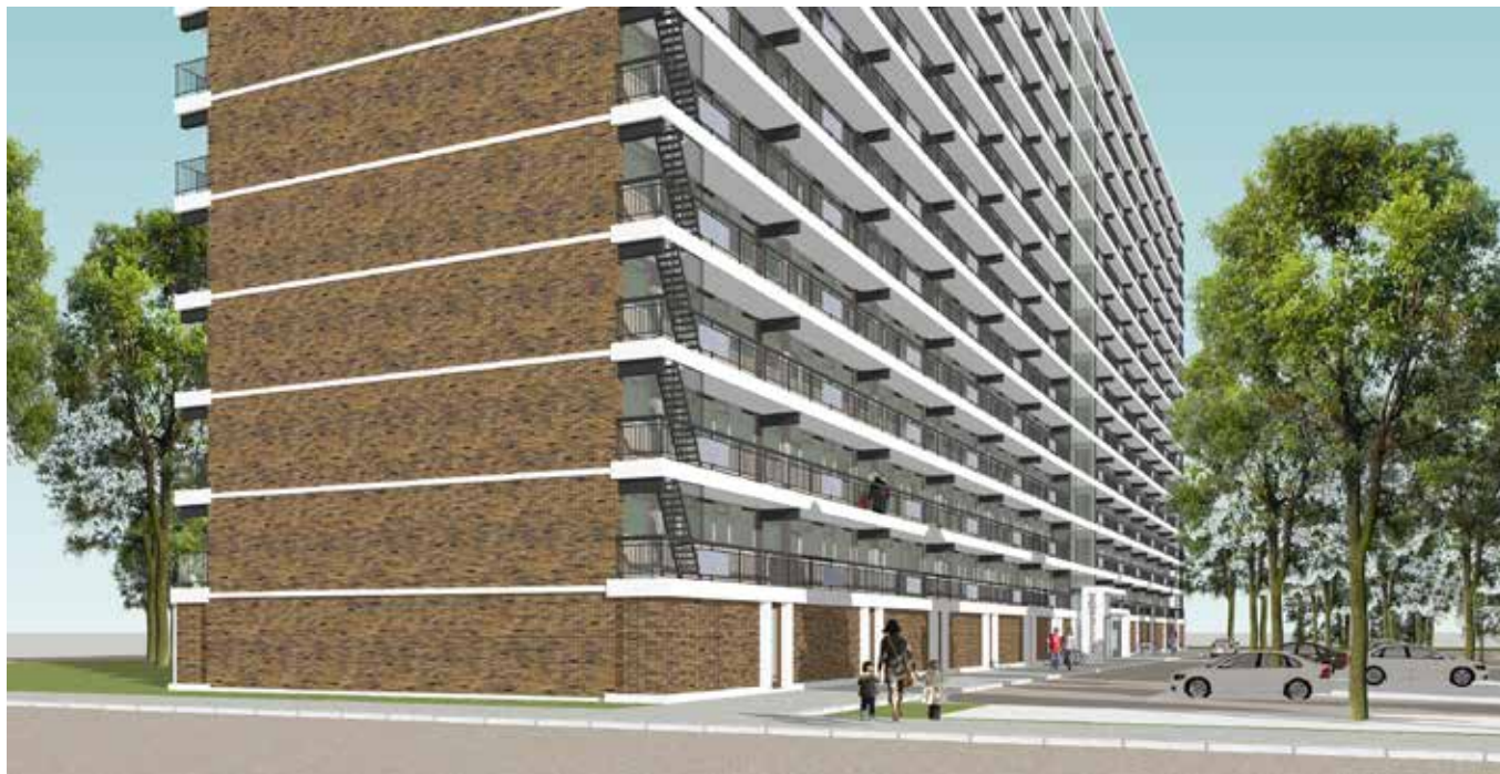
Geïsoleerde kopgevel met steenstrips en gevelbanden.
